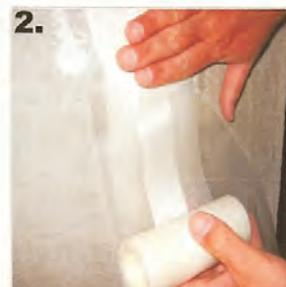
Das **Fugenband** mittig dem Fugen-/Rissverlauf folgend anlegen und mit der Handfläche falten- und blasenfrei andrücken.
